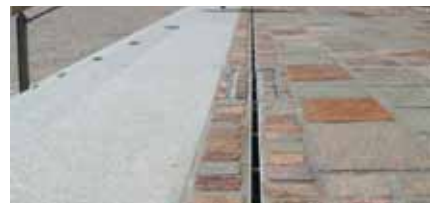
ACO Schlitzrinnen Die unauffälligste Form der Linienentwässerung
